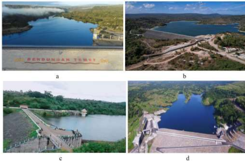
Gambar 6. Ketersediaan bendungan di Pulau Timor NTT; (a) Bendungan Temef; (b) Bendungan Raknamo; (c) Bendungan Tilong; (d) Bendungan Rotiklot.
